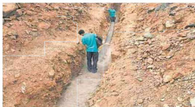
Nuevos colectores de agua en El Roque, en Gáldar. c7
