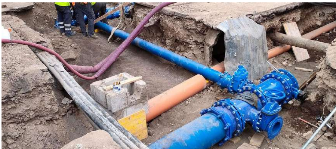
Obras de mantenimiento y mejora de la red hidráulica
